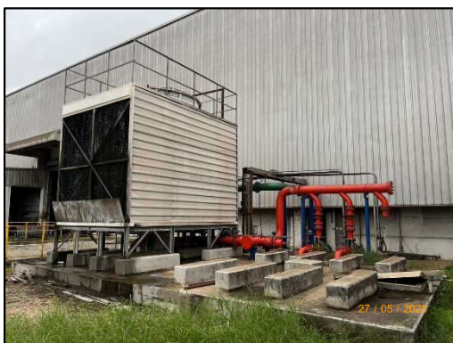
รูปที่ 3-8 Cooling Tower
