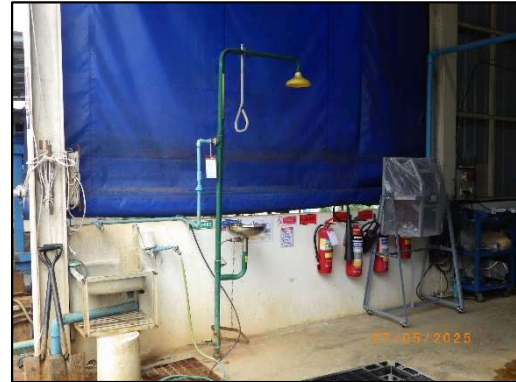
รูปที่ 3-29 อ่างล้างตาและฝักบัวฉุกเฉิน
