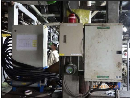
รูปที่ 3-54 การติดตั้ง Hydrogen Gas Detector
