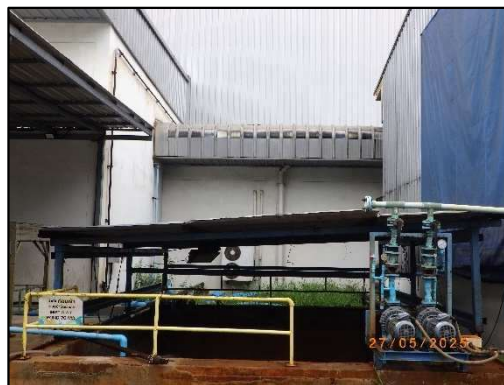
รูปที่ 3-7 ถังรวบรวมน้ำเสีย (Storage Tank) ขนาด 30 ลูกบาศก์เมตร
